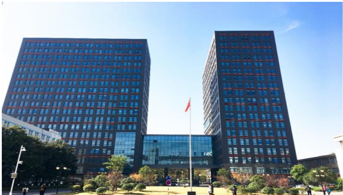
图：江苏财税邦科技有限公司办公大楼（南财科技园）
